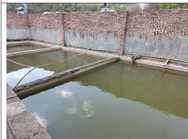
照片 31 消防水池
