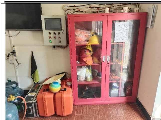
照片 35 应急物资器材柜和液位控制器
