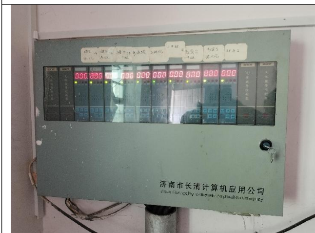
照片 33 可燃气体报警控制器
