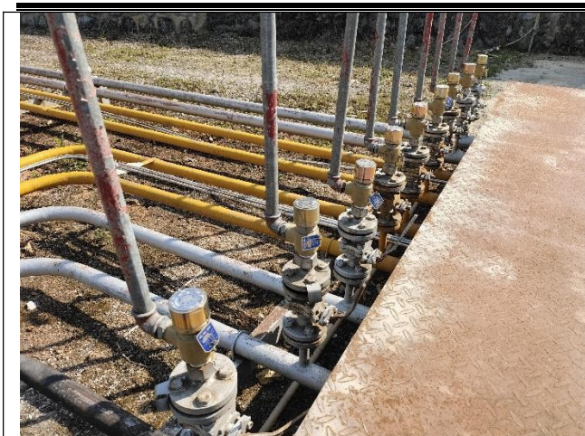
照片 11 管线上的安全阀
