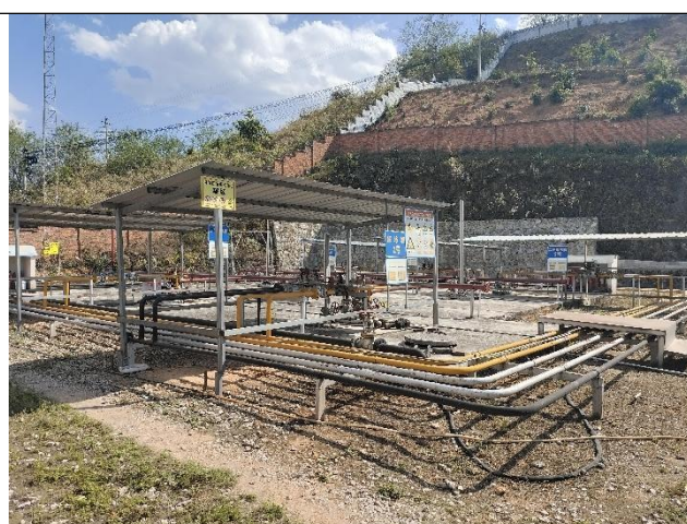
照片 38 罐区外围环境
