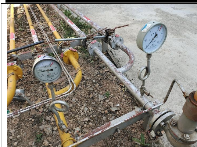
照片 17 工艺管线上的压力表
