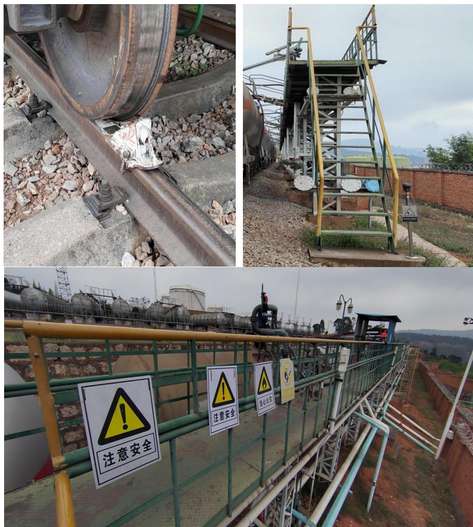
图2-11 防溜铁鞋、人体静电导除装置、安全警示标识
