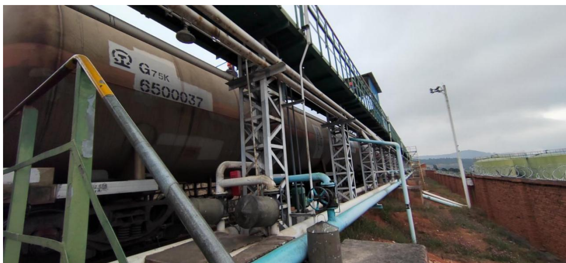
图 2-3 铁路卸油栈桥
